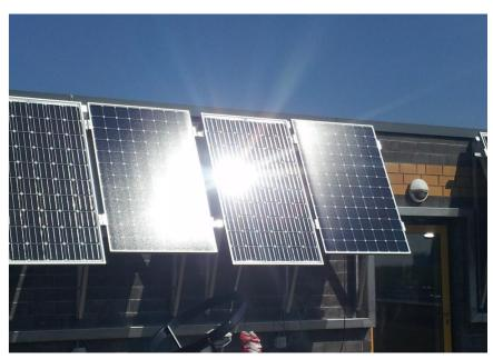
Abbildung 6: Veranschaulichung der Reflexion an einem texturierten Modulglas (mitte-links) und einem glatten Modulglas (mitte-rechts) – Quelle Aufnahme: Fraunhofer-Institut für Solare Energiesysteme ISE
